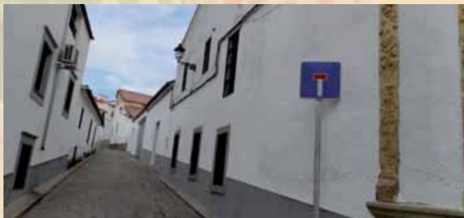
SEÑALIZACIÓN CALLE CORTADA ALBARDEROS
