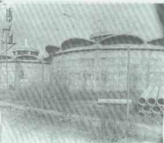
Depósitos de Agua.
