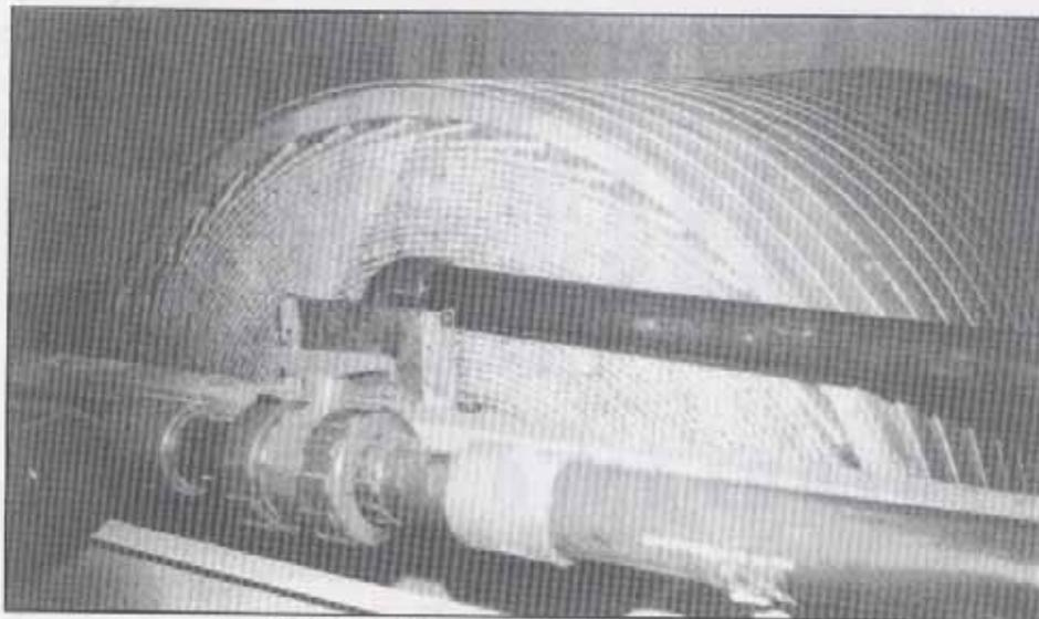
Depuradora de aguas residuales por biodiscos
