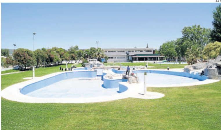
►► Una vista de las instalaciones de las piscinas municipales, que abrirán el día 22.
