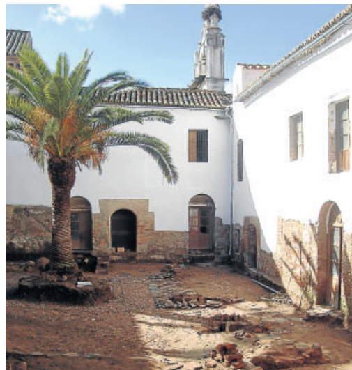
► Obras del nuevo hotel de Pedroche, en el convento concepcionista.
