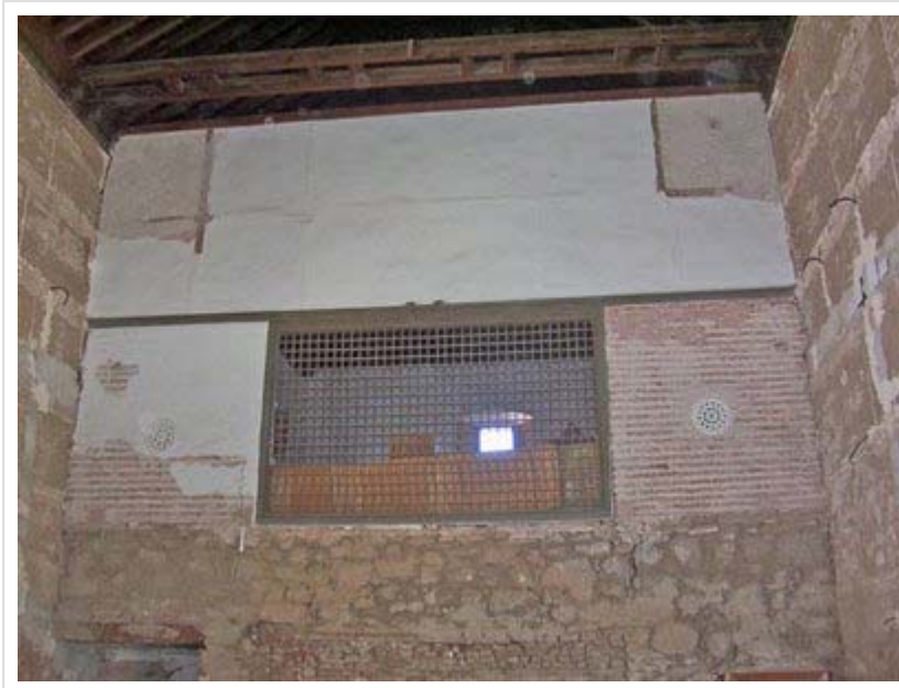
Celosía del coro de la clausura, en la iglesia del convento.
