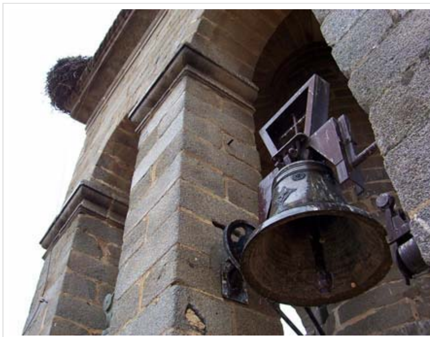
Detalle del campanario de la torre de Pedroche.
