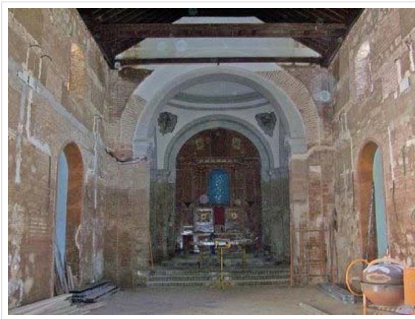
Interior de la iglesia del Convento de la Concepción.
