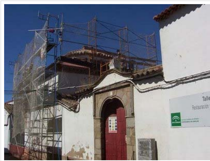
Vista de las obras de restauración del convento desde el exterior.
